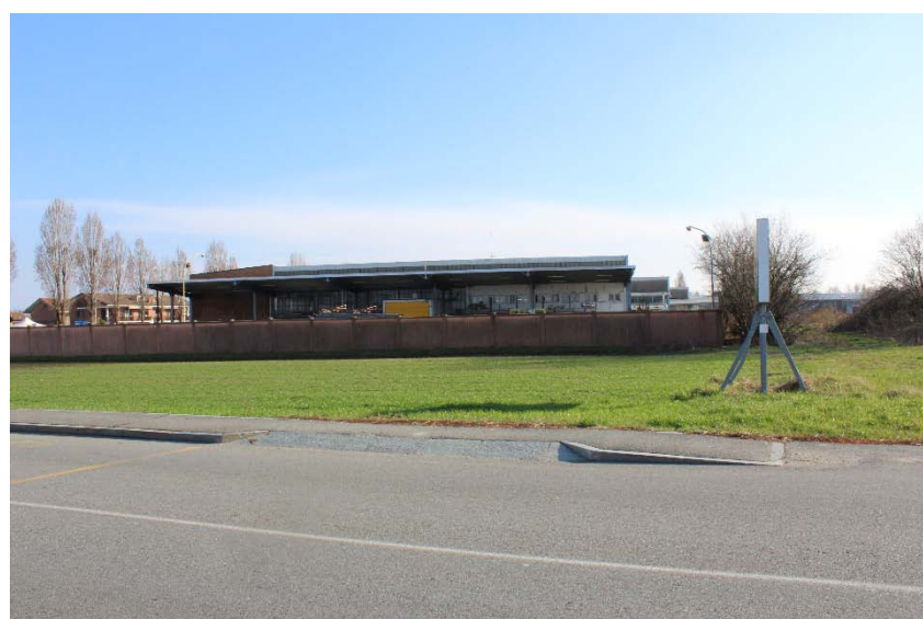
Foto 4 - Vista da Via San Massimo (interruzione del percorso pedonale esistente)
