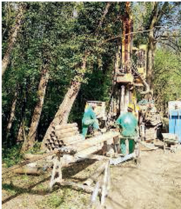
RIVALTA - Oltre a strada Dojrone, i test delle trivelle hanno interessato anche il Comune di Buttigliera (nella foto).
