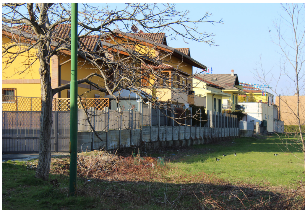
Immagine 2 - Vista dal lato sud dell'area del P.E.C.L.I.
