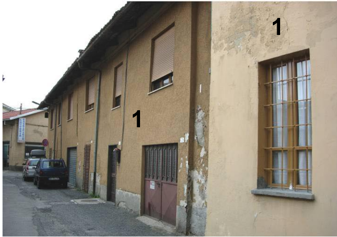
A. Vicolo S. Martino, lato destro
