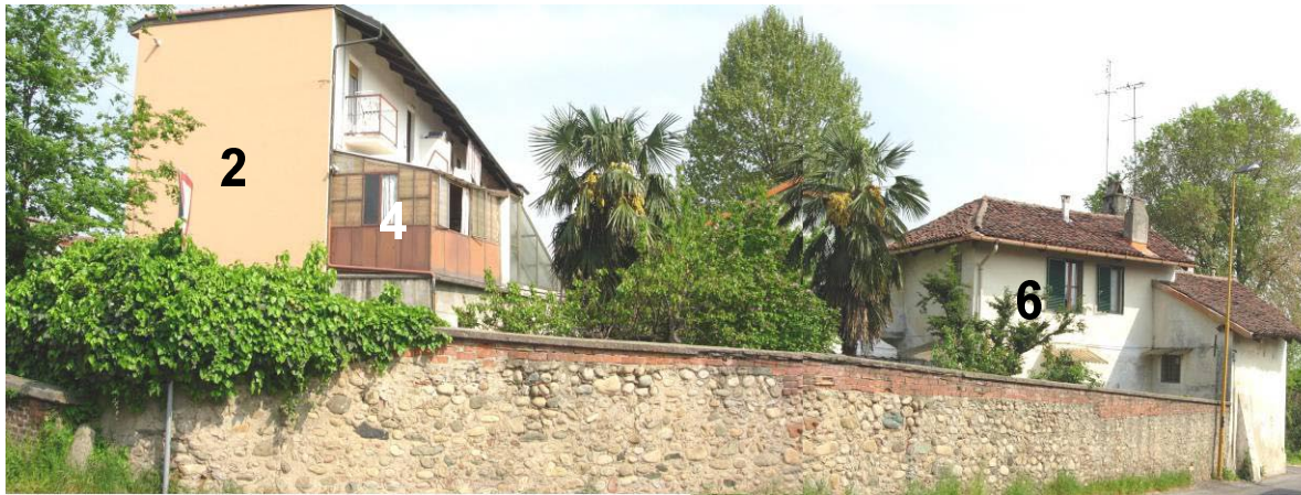
B. Via Umberto I n. 67 – retro da via Della Vallà
