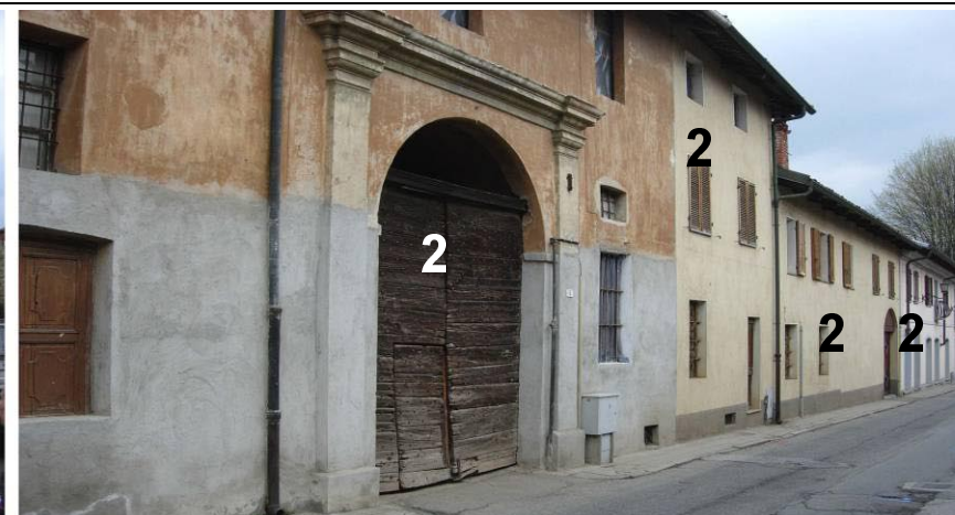
C. Via Umberto I tra via XX Settembre e via Griva
