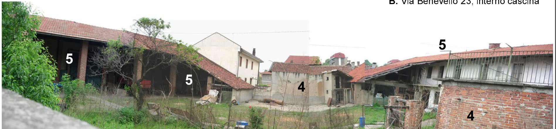
B. Via Benevello 23, interno cascina
