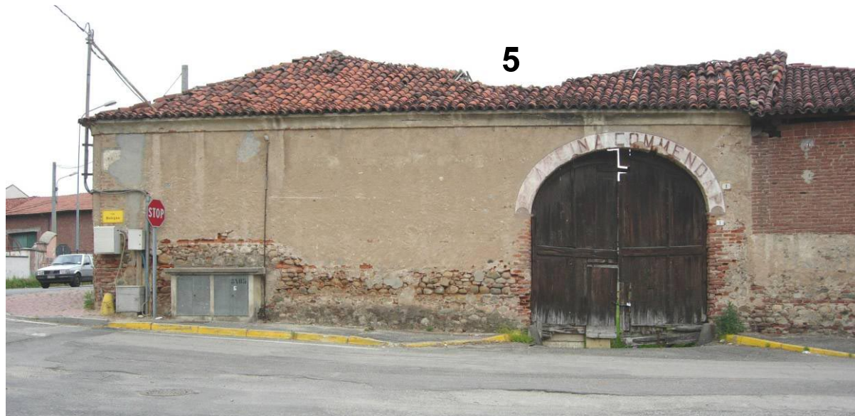
A. Via Balegno 1, ingresso cascina Commenda
