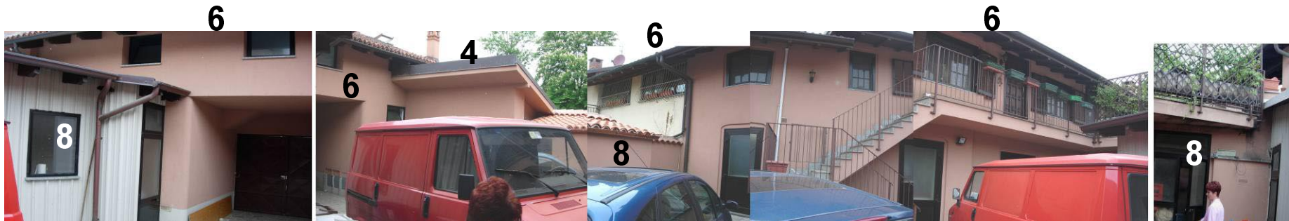
Via Mellano 2 (via Roma 10, interno)
