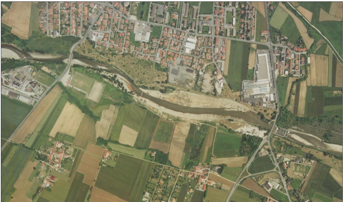
Foto 12 - Torrente Sangone – Tracce dell’evento dell’ottobre 2000 nel tratto D-E – (ripresa aerea del 2002) - Lunata in sponda destra e tracimazione in sponda sinistra a monte del ponte della S.P. 143 ricostruito con maggior luce nel 2005.
