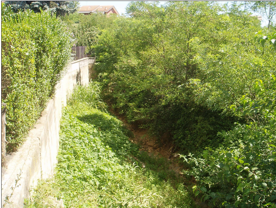
Foto 4 - Garosso di Rivalta – Imbocco della varice presente sul lato orientale della S.P. 143 e percorsa dal Garosso al piede della scarpata.
