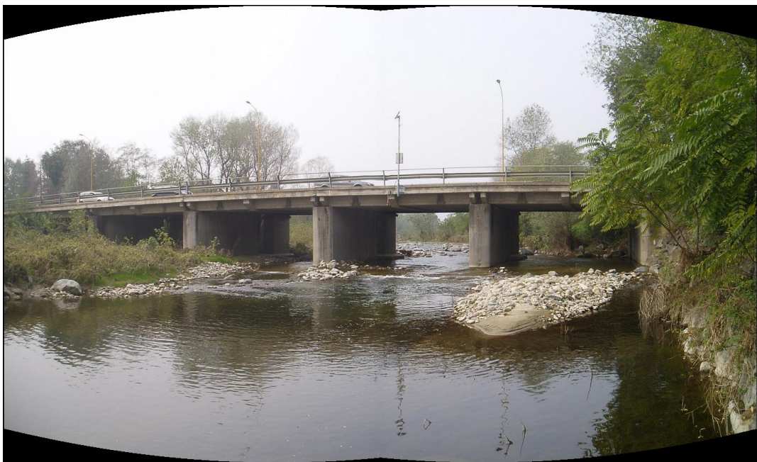
Foto 20 – Torrente Sangone - Ponte di Via Piosasco visto da valle (manufatto PO001 delle schede SICOD)
