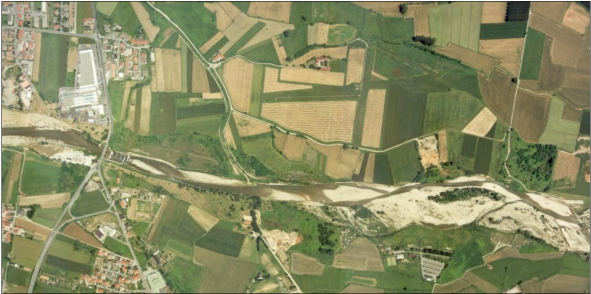
Foto 13 - Torrente Sangone – Tracce dell'evento dell'ottobre 2000 – Ripresa aerea del 2002 – Tronco a valle del ponte sulla SP 143 - Lunata in sponda destra in territorio di Orbassano e corrispondente erosione in sponda sinistra
