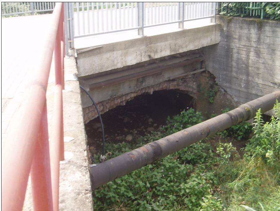
Foto 2- Rio Garosso di Rivalta – Attraversamento di via G. Griva.
