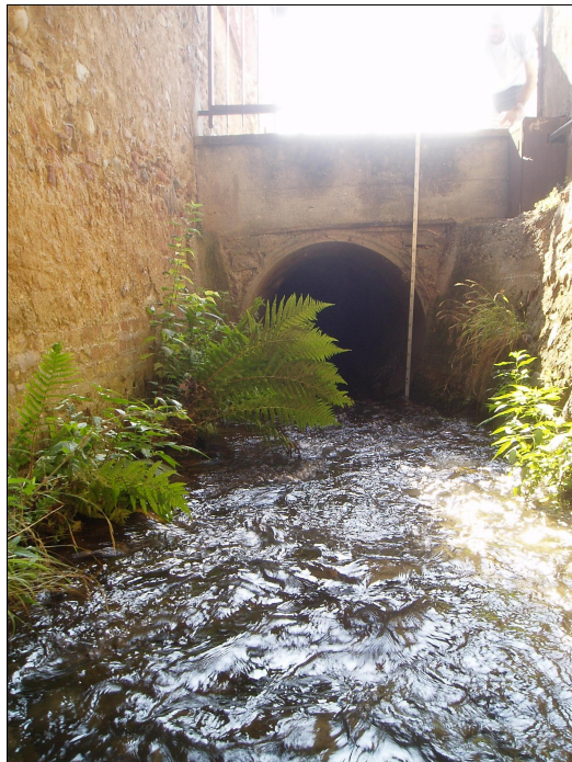
Foto 6 – Bealera comunale di Rivalta – Imbocco del tratto tombato sotto Via Millio (foto 662-P8100137)
