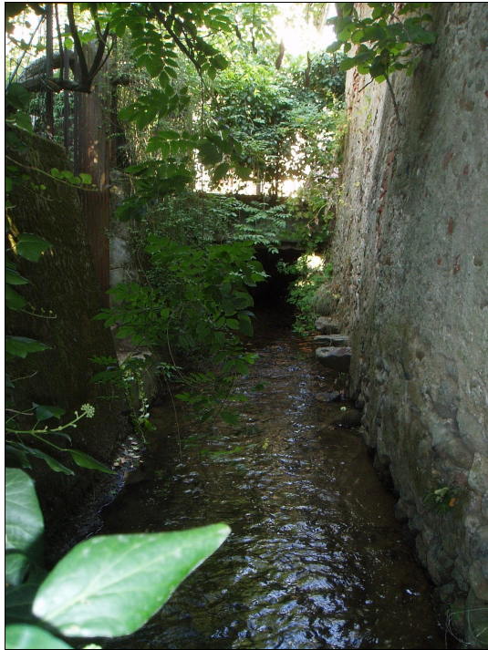
Foto 5 – Bealera Comunale di Rivalta – Vista del tratto grosso modo parallelo a Via Millio, dove il canale corre incassato fra edifici.
