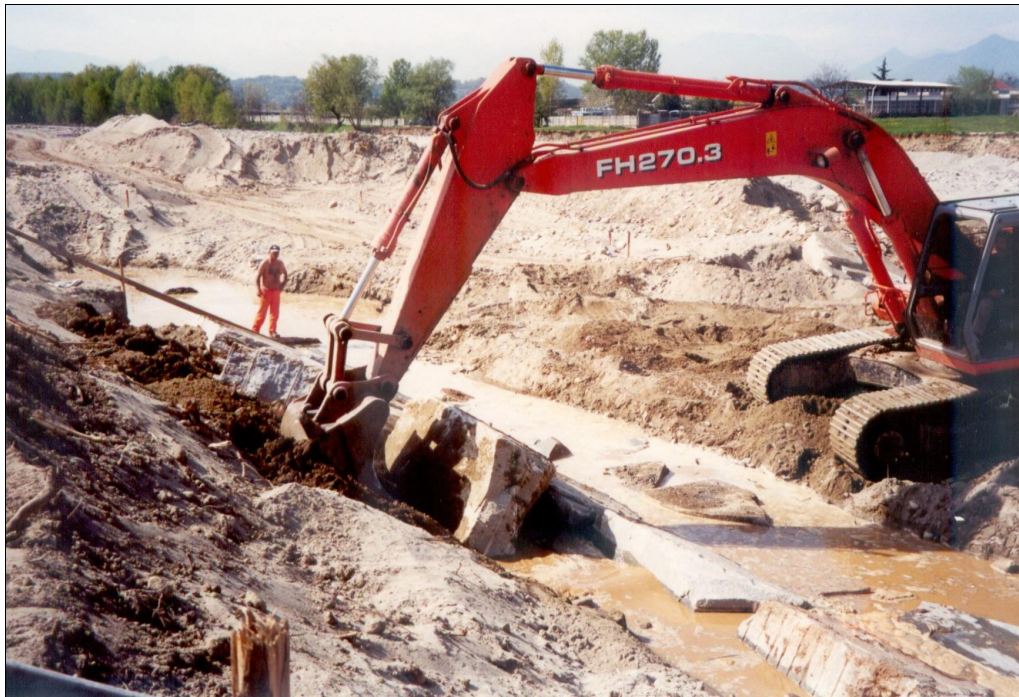
Foto 22 – Torrente Sangone – Realizzazione della difesa di sponda a monte del ponte della S.P. 143 durante i lavori (si osservi l'ingente cumulo di materiale litoide presente sul posto a causa del rallentamento indotto dalla presenza del sifone della Bealera di Orbassano) (foto 189-7)
