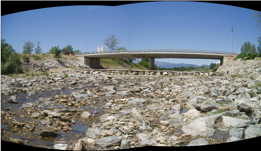
Foto 23 – Torrente Sangone – Vista da valle del salto di fondo a valle del sifone del Canale di Orbassano dopo l'abbassamento realizzato nel 2005 e, in secondo piano, il nuovo ponte ricostruito, con maggior luce, al posto del precedente a tre campate.
