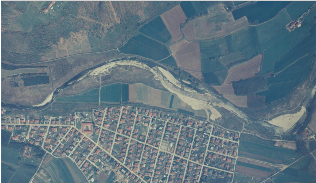
Foto 7 – Torrente Sangone dopo la piena del marzo-aprile 1981 nel tronco al confine con Bruino, di cui si vede la lottizzazione del Villaggio Alba Serena. In alveo ci sono le tracce dei lavori in corso per la realizzazione della difesa della sponda destra.
