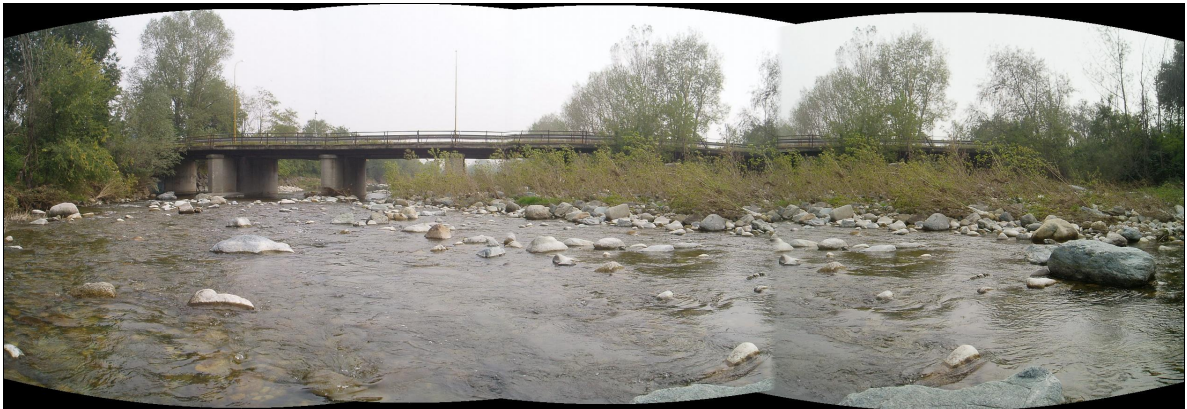
Foto 19 – Ponte di Via Piosasco visto da monte (situazione di ottobre 2006)
