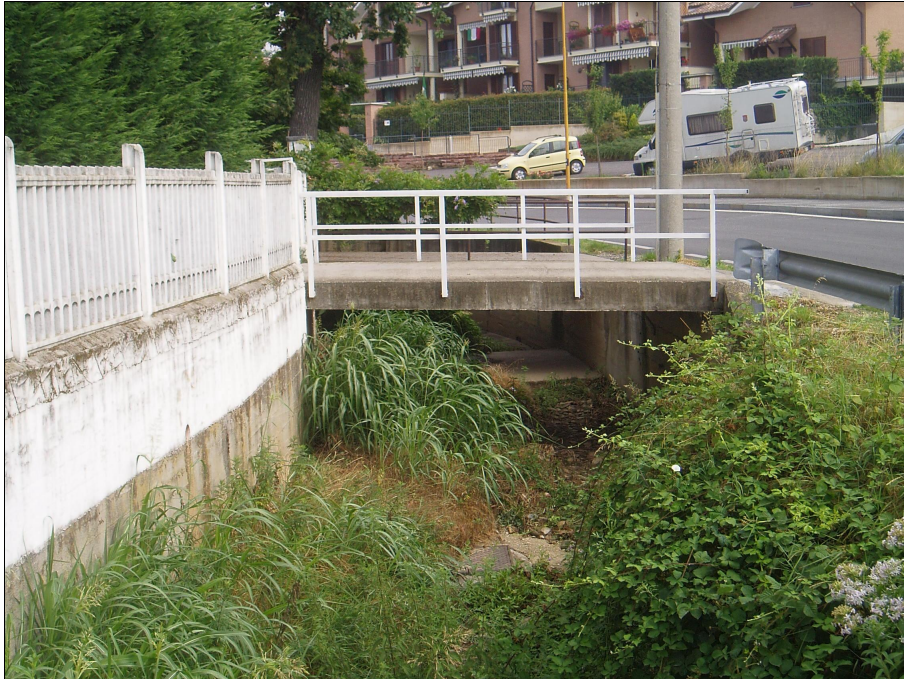
Foto 1- Rio Garosso di Rivalta – Ponticelli di accesso a residenze private.
